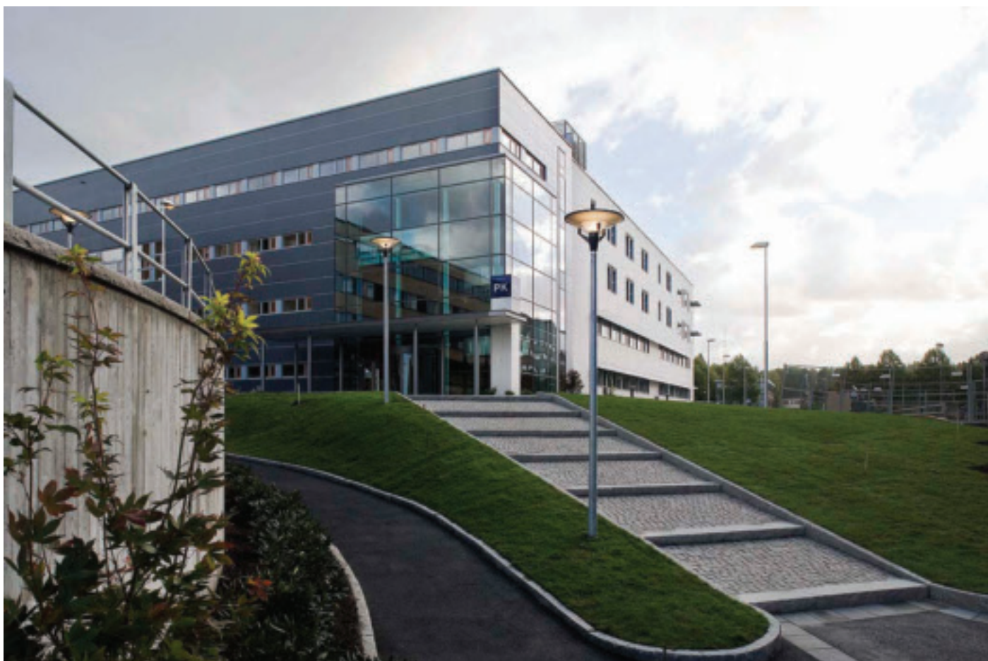
Byggnaden har en stram arkitektur med artikulerade fasader i en sval färgskala.
